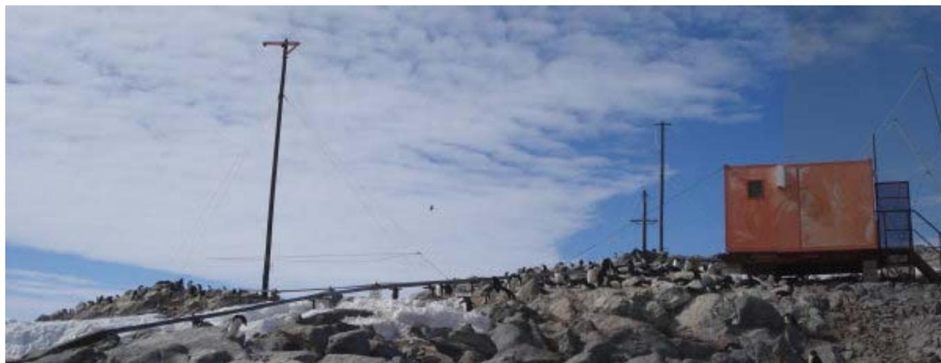
**FT5YI station mini : A droite le Shelter dans lequel se trouve la station et à gauche la delta loop pour le 20m, tendue à l'horizontale à 2m du sol.**
